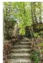
Sa.V, Waldzone, Treppe zum ehemaligen Holzstoßhäuschen, DI007874, BSV-
